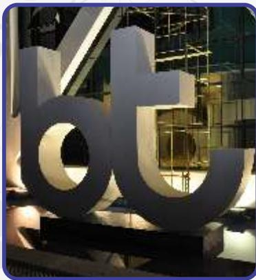
Totem em estrutura metálica revestida com ACM
