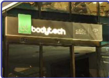
Placa em chapa galvanizada com pintura automotiva com logomarca em acrílico com iluminação em LED por trás
