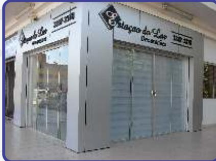
Revestimento de fachada em ACM com letra caixa em chapa galvanizada com pintura automotiva
