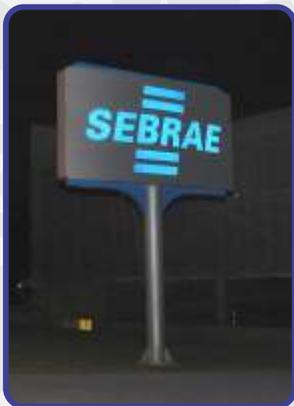
Totem em estrutura metálica revestida com ACM com logomarca vazada com acrílico e iluminação por trás
